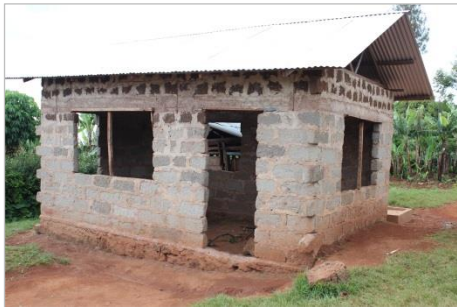
Rohbau neue Küche
